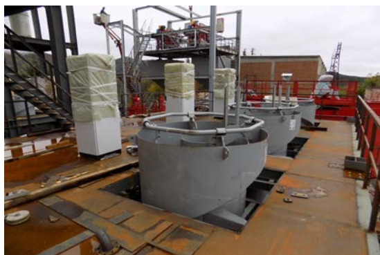
Рисунок 3 – Монтаж флотомашин КФМ-600 на МОУ-15 «Рудметал» АД
