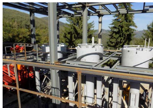
Рисунок 3 – Монтаж флотомашин КФМ-600 на МОУ-15 «Рудметал» АД
